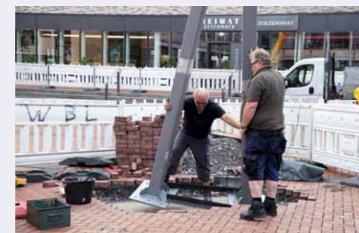
Präzisionsarbeit: Die Füße der zwei Tonnen schweren Figur wurden passgenau ins Fundament dirigiert.
